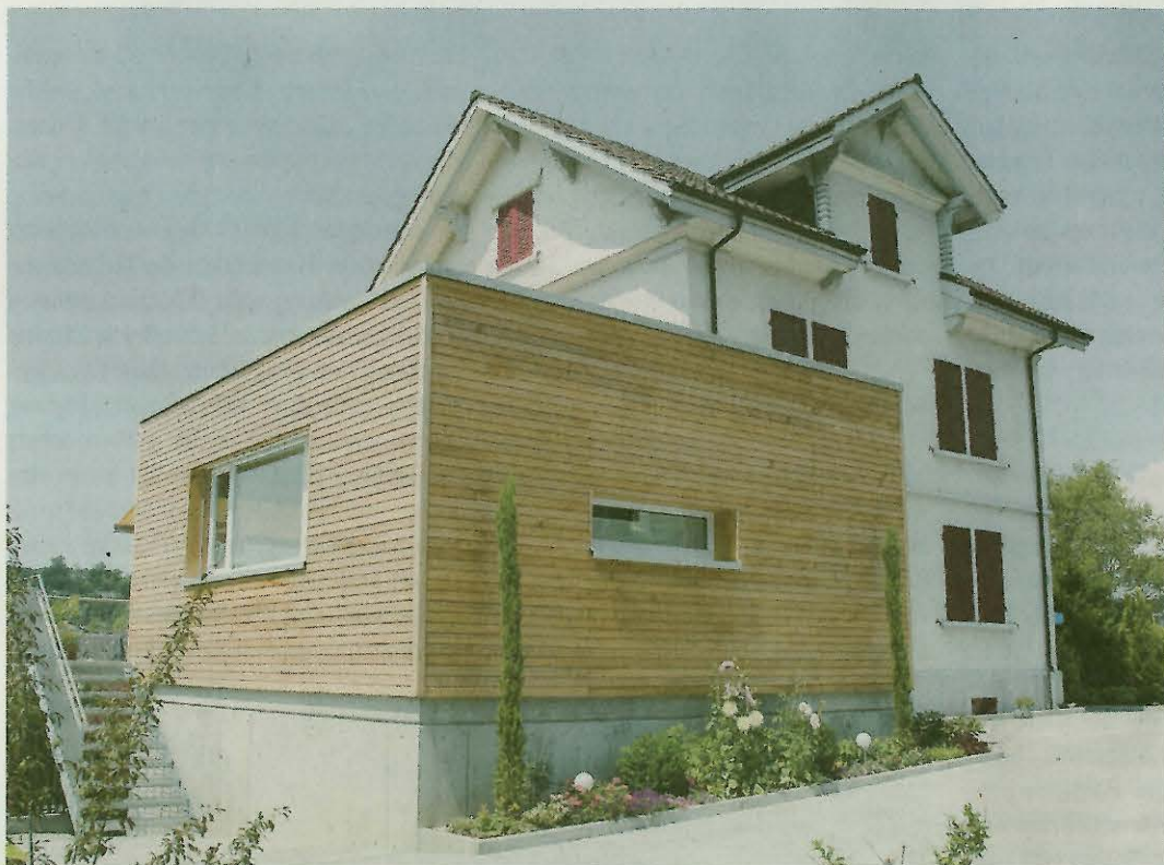
Der Um- und Anbau des Einfamilienhauses bringt neue Lebensqualität.
