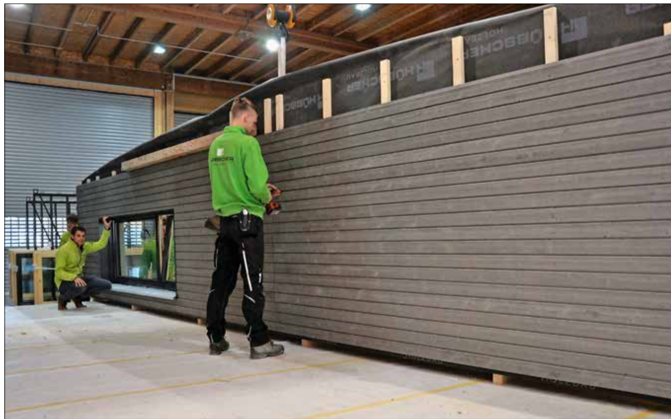
Gesamtproduktion in der Werkstatt: Die 13 Meter langen Aussenwände des Einfamilienhauses Burr werden mitsamt Verschalung bei Holzbau Hübscher in Beringen fertiggestellt. Als letzter Schritt werden noch die Fenster samt Laibungen einmontiert.
