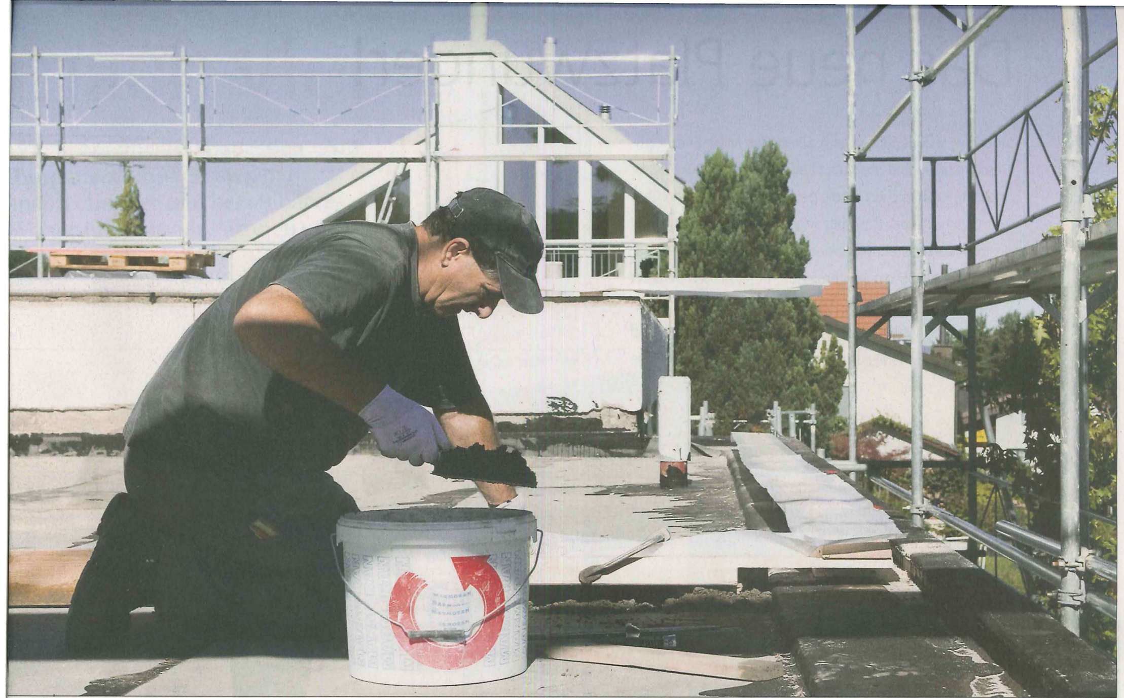
Sorgfältige Isolation des Daches bei einer von Rüegg Architekten, Zürich, geplanten Aufstockung und Sanierung eines Doppelfamilienhauses in Gockhausen (ZH).
